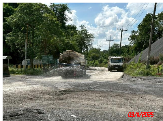
รูปที่ 11 การฉีดพรมน้ำเพื่อลดการฟุ้งกระจายของฝุ่นละอองจากกิจกรรมการขนส่งแร่
