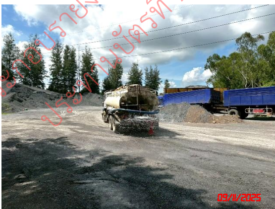
รูปที่ 11 การฉีดพรมน้ำเพื่อลดการฟุ้งกระจายของฝุ่นละอองจากกิจกรรมการขนส่งแร่
